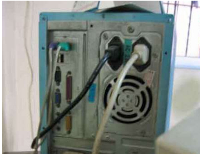
Gambar 30. Pemasangan Kabel Power
